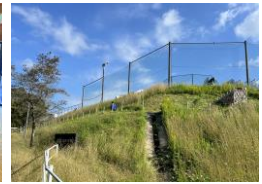
グラウンド法面
